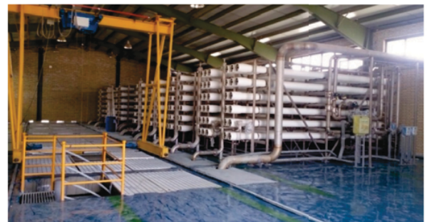
شکل ۲- نمایی از مدول های غشایی تصفیه خانه بیرجند
